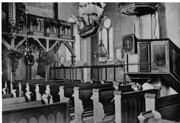
Wnętrze kościoła w Helu (ok. 1930 r.)
